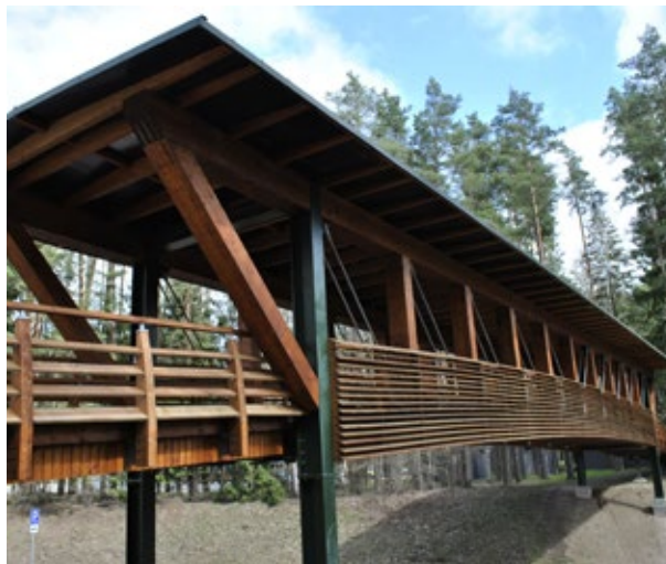
SIA „IKTK” izstrādātais, izgatavotais un uzstādītais liekti līmēto lielizmēra koka konstrukciju gājēju tilts pār šoseju pie ieejas Tērvetes dabas parkā
