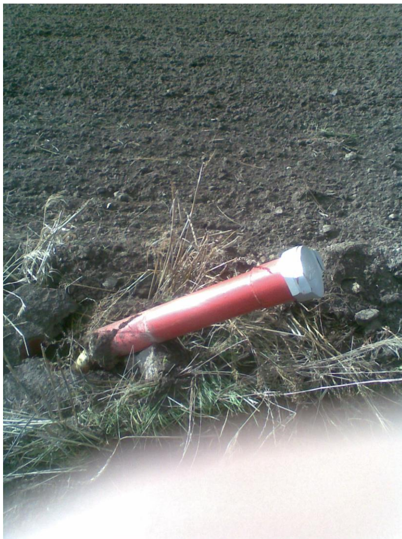
5.3.Sabojātais gruntsūdeņu urbums SG-2 Staļģenes monitoringa stacijā.
