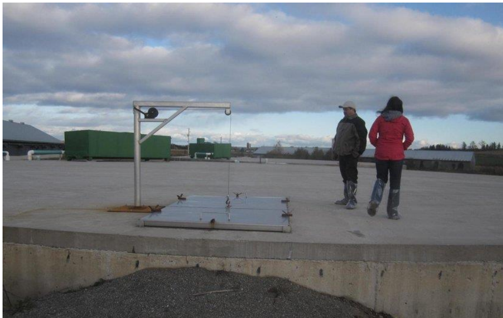
13. attēls. Šķidrmēslu krātuve ar betona pārsegumu
