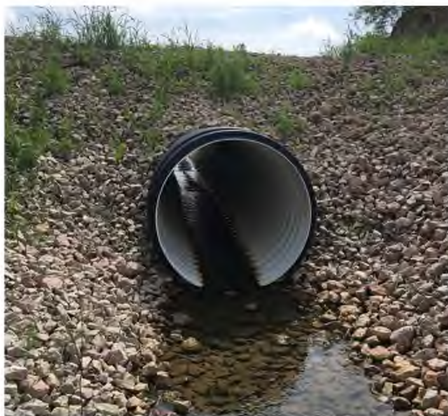
49. att. Bērzes 2.vietas grāvja beigu caurteka.
