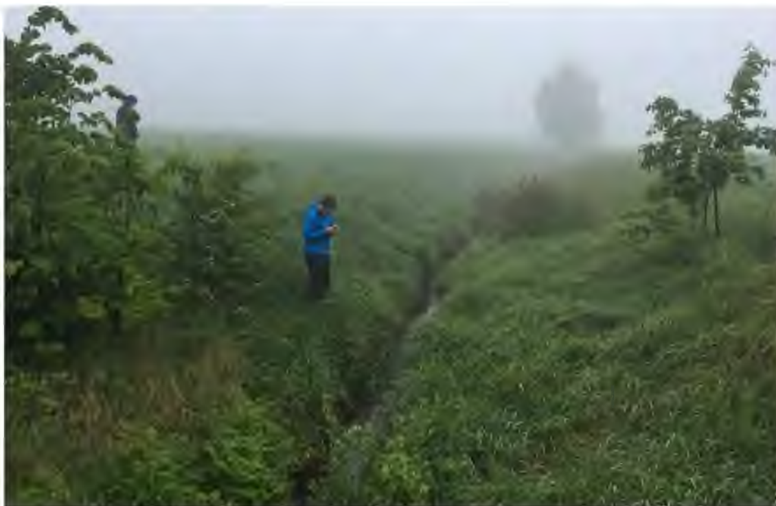
14. att. Skats uz Mellupītes 2.vietas grāvi no sākuma caurtekas.
