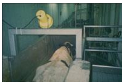
23.attēls. Papildus gaismas elements virs ejas uz apdullināšanas boksu, kurš to izgaismo ( www.grandin.com )
