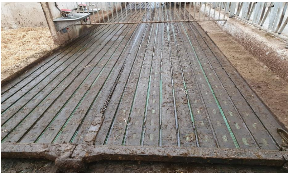
10. attēls. Kūtsmēslu izvākšanas sistēma ar skrāpjiem, kas aprīkoti ar metāla pirkstiem
